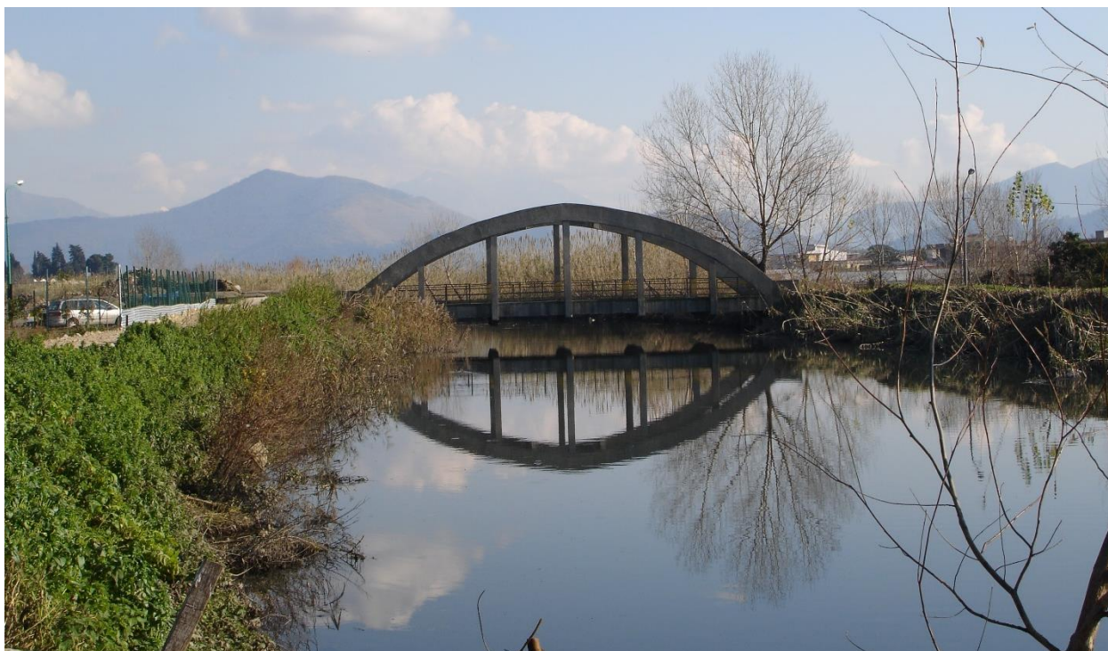
Figura 14: Ponte di attraversamento del Fiume Sarno nel territorio di San Marzano sul Sarno
